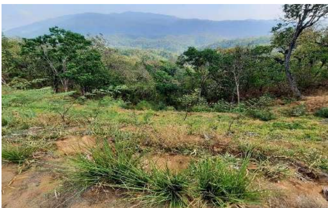
ทล. 1095 ตอน กิ่งคอกหมา-แม่ตะ กม.75+500 จ. แม่ฮ่องสอน
